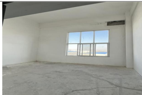
项目破碎间现状
