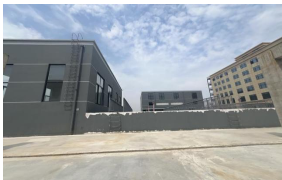
依托消防水池
